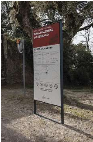
Modelo tipo cartel informativo, compuesto por estructura de perfiles tubulares, so- bre los que se fija panel de compo- site de 30 mm con vinilo. Medidas aproximadas 1.00 x 1.50 m
